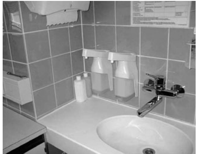
Beispiel eines Händewaschplatzes (Hinweis: Auswahl zufällig; auch vergleichbare Desinfektionsmittelpender und Einhebel-Armaturen sind geeignet).
